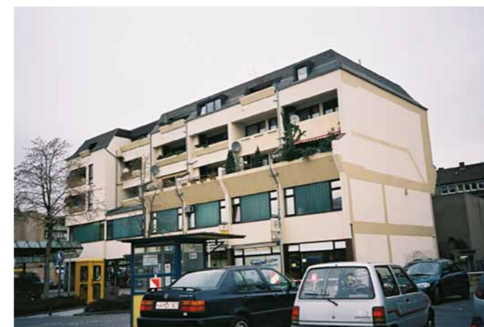
das Wohn- und Geschäftshaus ragt mit einer hohen Brandwand in den Blockinnenbereich
