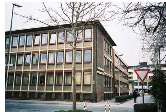
der III-geschossige Verwaltungsbau des Gesundheitsamtes
