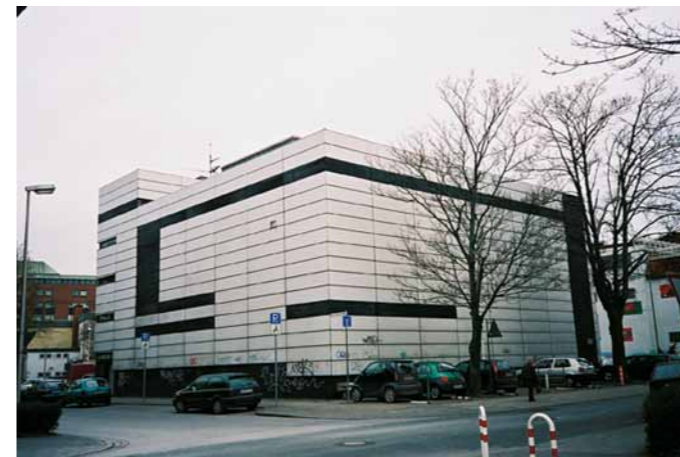
die Trafostation bleibt erhalten
