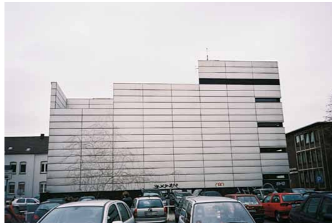
Großformatige Infrastrukturen, wie hier die Trafostation, prägen den Block
