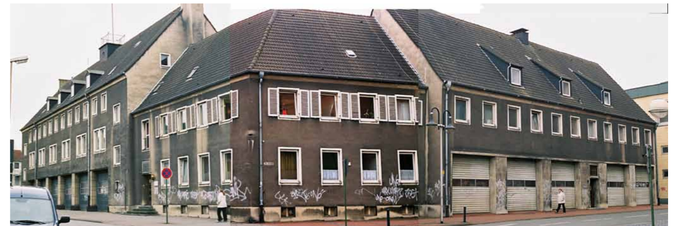
die Gebäude der alten Feuerwache befinden sich in schlechtem Zustand
